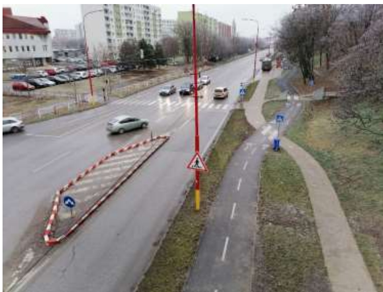
Obrázok 24 Kríženie chodníka pre cyklistov s chodníkom pre peších v priestore autobusovej zastávky
