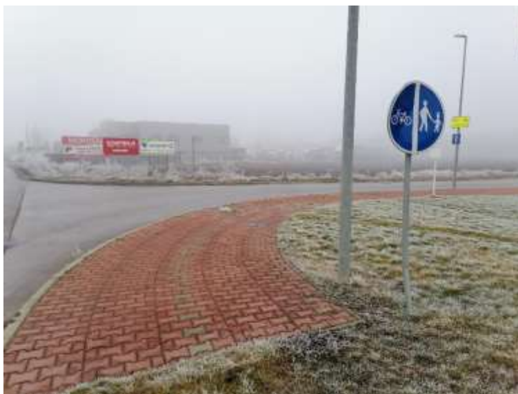
Obrázok 33 Bariérový nájazd z hlavnej cesty na cyklotrasu na Zavorskej ulici
