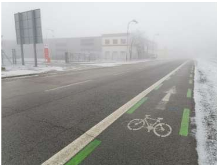
Obrázok 21 Spôsob značenia cyklopruhu na Strojárskej ulici
