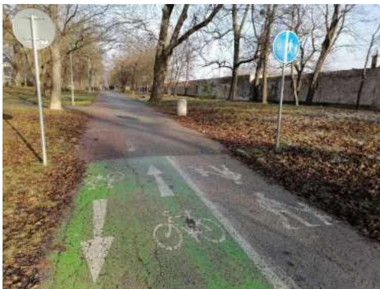
Obrázok 38 Zúženie cyklopruhu na polovicu a zmena povrchu cyklotrasy v parku Janka Kráľa
