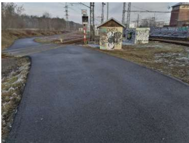
Obrázok 44 Začiatok cykloturistickej trasy v blízkosti železničného koridoru č. 120
